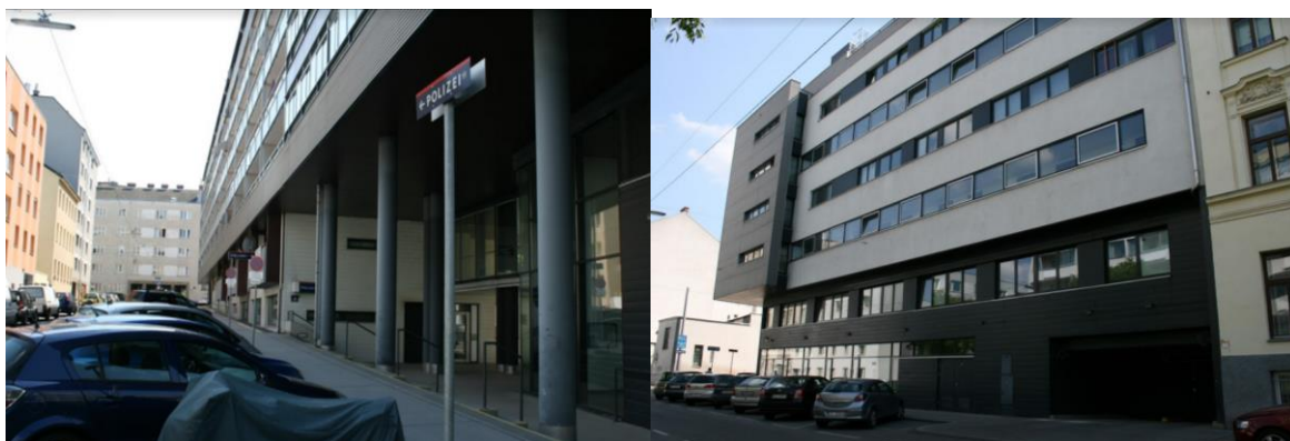
Fot.27. (z lewej): Widok na posterunek policji w parterze budynku.
